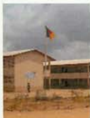
日本の援助で建設された小学校
